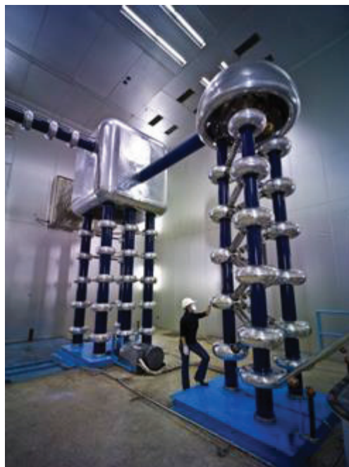
Figure 96 : Photographie du même générateur de haute tension Cockcroft-Walton, 01/26/1993, photographe : Reidar Hahn. Fermilab, États-Unis.
