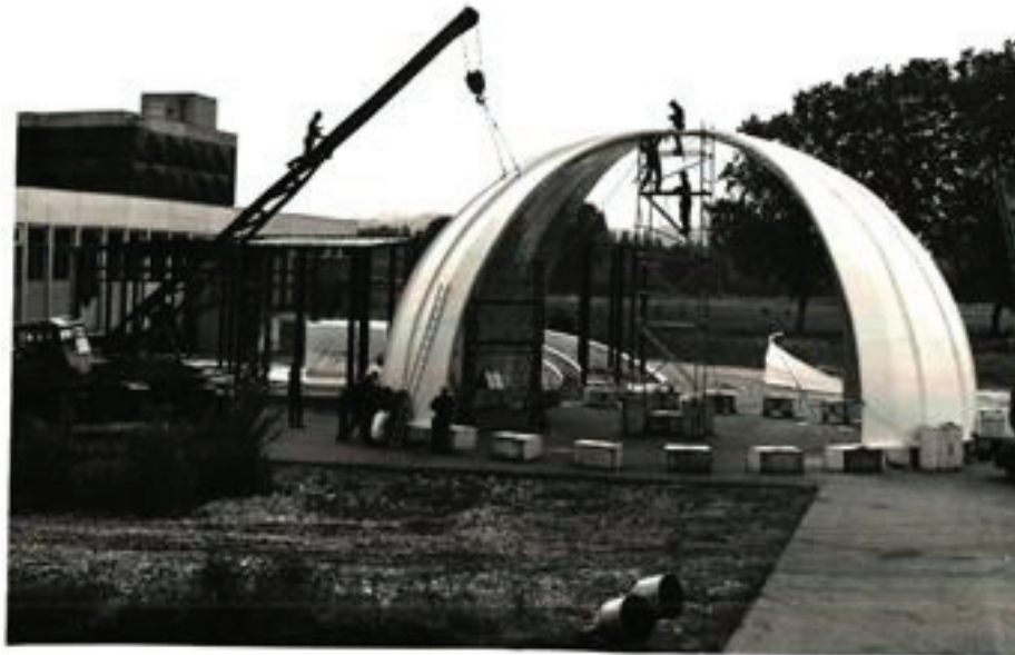
Figure 25 : Le Dôme lors de sa construction (1969). Sources : archives de l'IPNL
