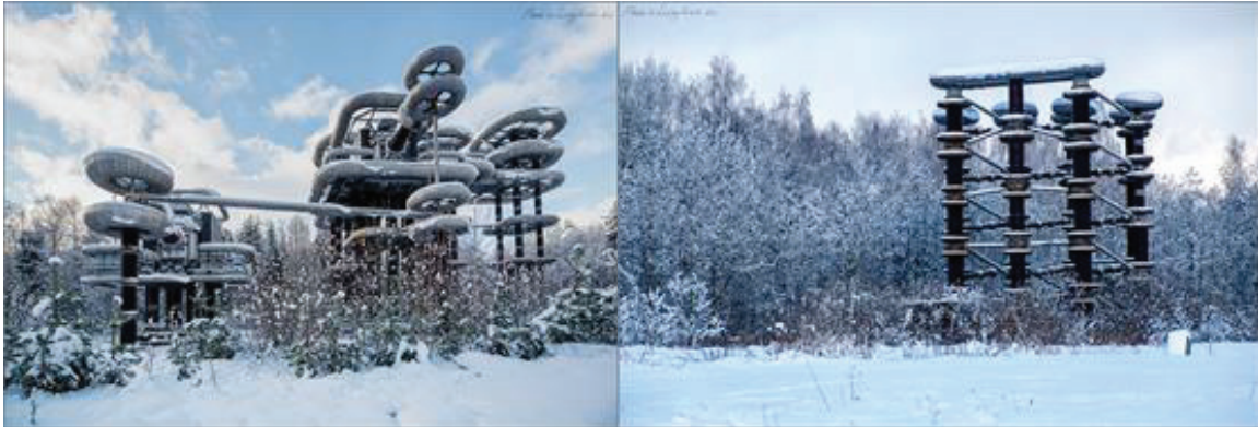
Figure 49 : installation de haute tension sur le site d'Istra, Russie, 2013. Droits photographiques : Elena Liseykina Petrova. Source : (Liseykina, 2013)
