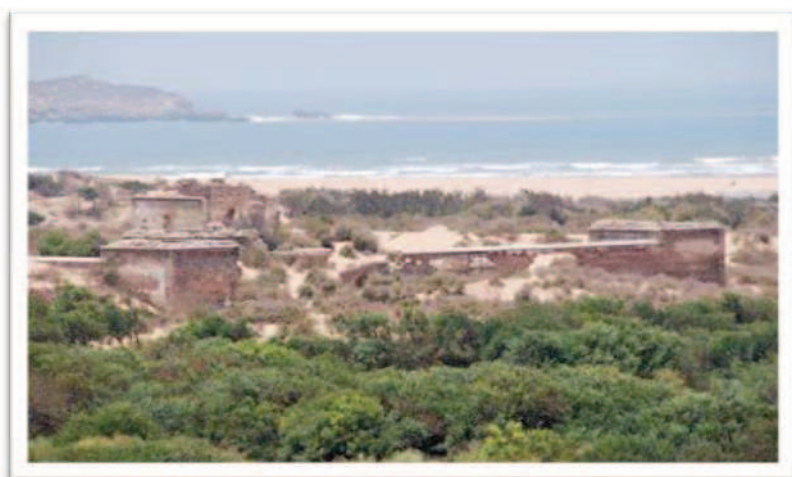
Figure n° 16 : Délabrement de la maison du Sultan
