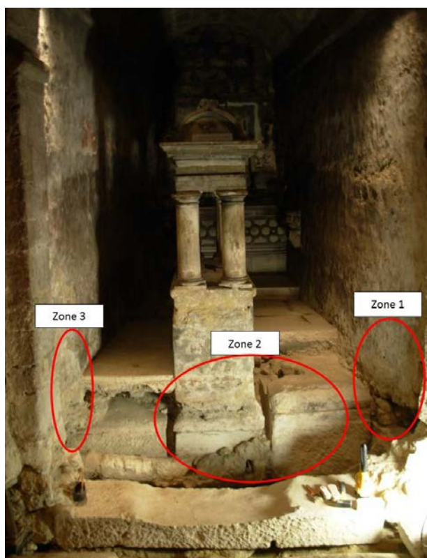
Figure VII-4 : Chapelle Saint-Fort dans la crypte de la basilique Saint Seurin. Les prélèvements ont été effectués dans les trois zones marquées en cercles rouges.
