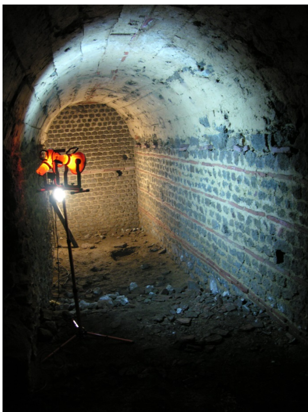
Figure IV-6 : Salle voûtée n°10, rez-de-chaussée des thermes (sous-terrain).
