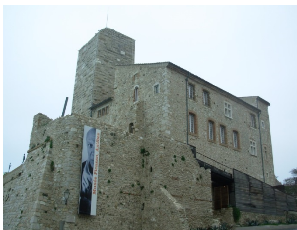
Figure III-2 : Vue extérieure du château, face nord.
