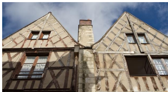
Figure 2 : Mur coupe-feu entre des maisons à colombages (datant du Moyen Age)
