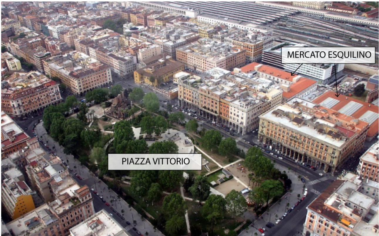
Fig.3 – Visione area dell’area di Piazza Vittorio con i due stabili del mercato e la stazione Termini in fondo
