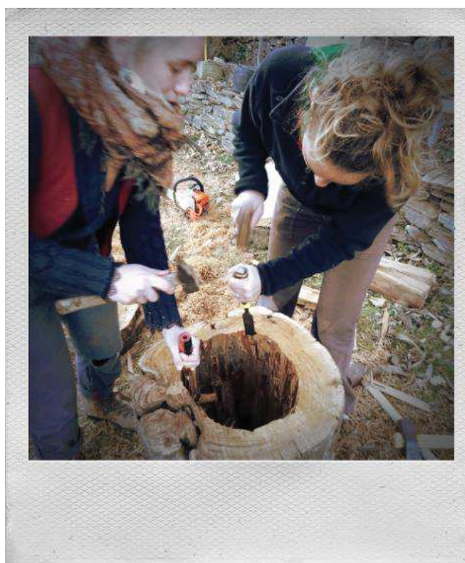
Figure 37 – Évidement du tronc au ciseau à bois (Photo : B. Boutin)
