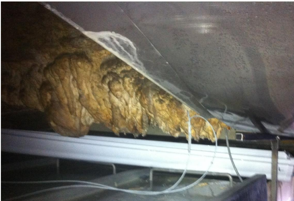
Figure V-6 : Photographie de la configuration du site de mesure dans le SAS 1 compartiment 3.
