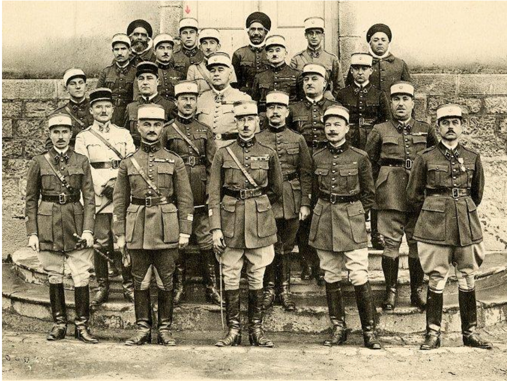
Officiers de la Portion Centrale à TLEMCEM.
