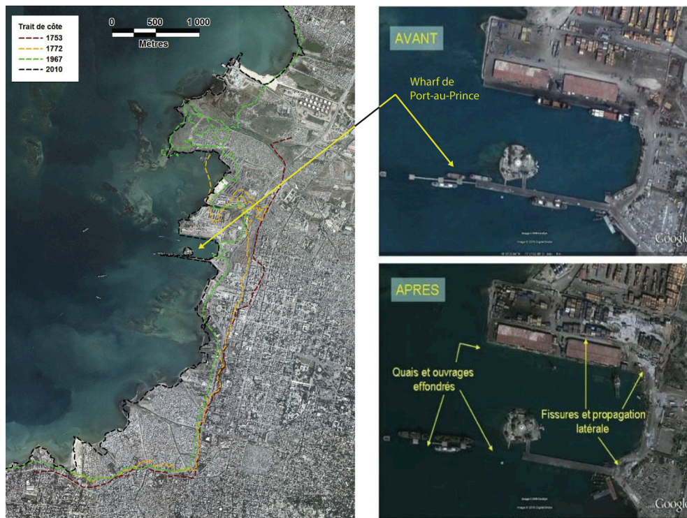
Figure 2.3.- A droite, zone de dépôt anthropique et variation de la ligne de côte entre 1753 et 2010. En haut à droite, les installations portuaires de Port-au-Prince avant le séisme d’Haïti du 12 janvier 2010 et en bas à droite, liquéfaction et effondrement des quais et ouvrages des installations portuaires après le séisme (Bertil et al. , 2014).
