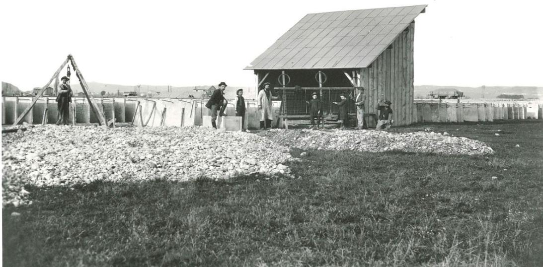
Figure 38 : Plaque photographique n°35 - Chantier des plaques en sidéro-ciment du 2<sup>ème</sup> lot
