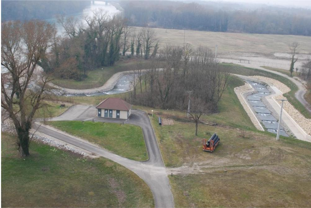
Figure 126 : Rivière artificielle – Passe à poissons en 2014 (collection personnelle)
