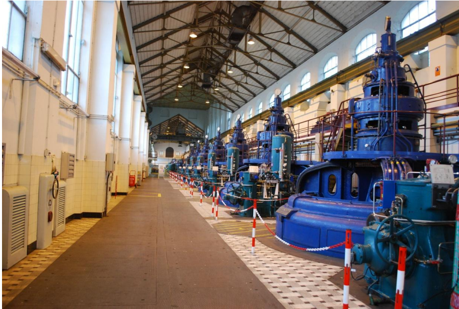
Figure 87 : Salle des machines de l'usine de Cusset en 2014 (collection personnelle)
