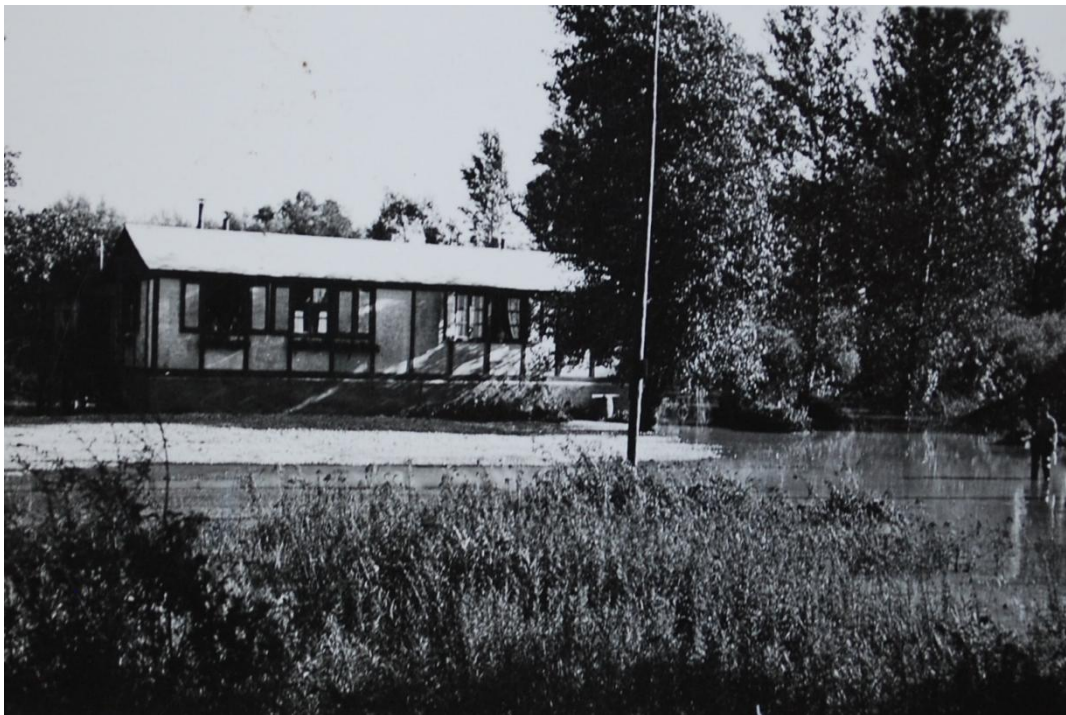
Figure 97 : Baraquement/dortoir du chantier de Jons en 1935 ( A.D.R. 3959 W 1295)
