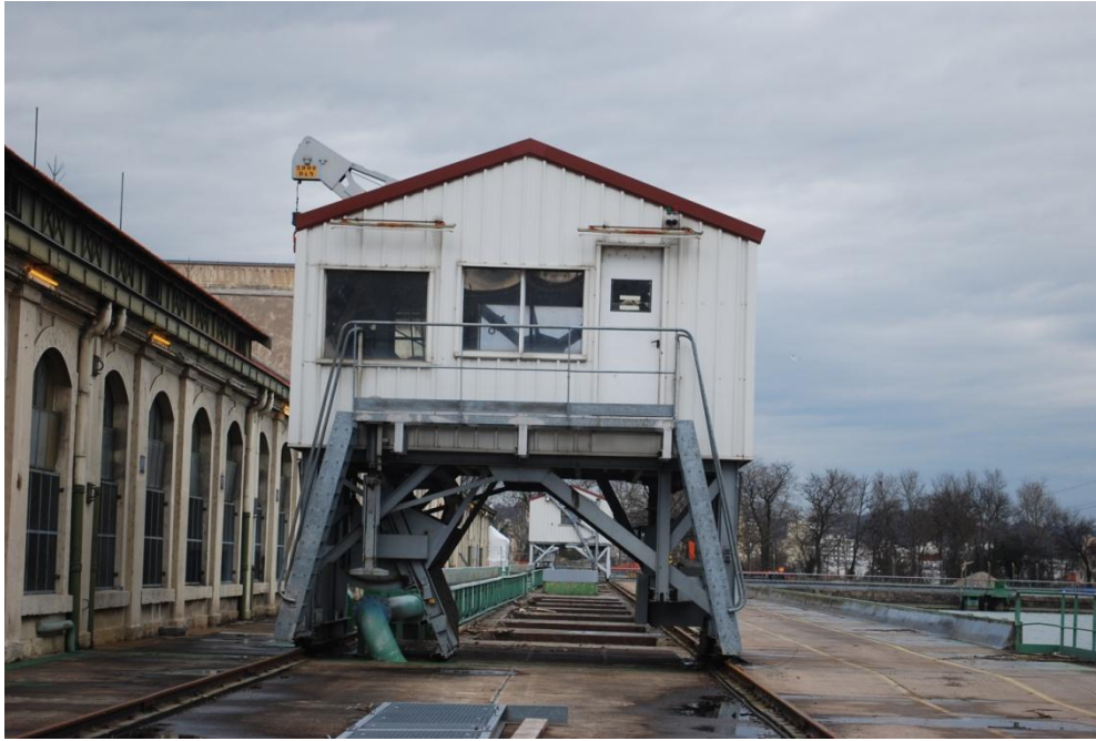
Figure 90 : Dégrilleurs de la plage amont, 2014 (collection personnelle)
