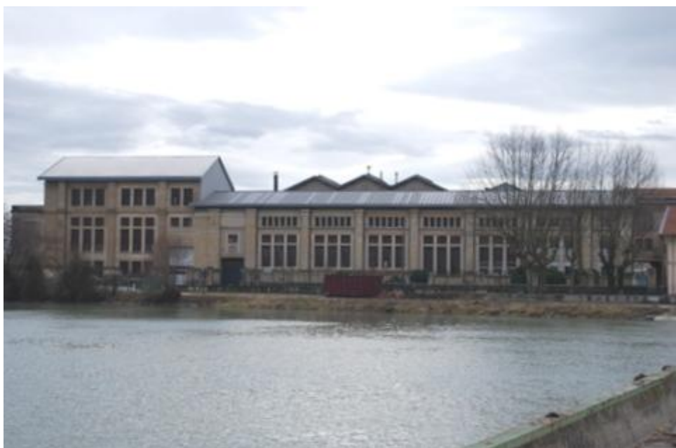
Figure 64 : Façade nord de l'usine thermique en 2014 (collection personnelle)
