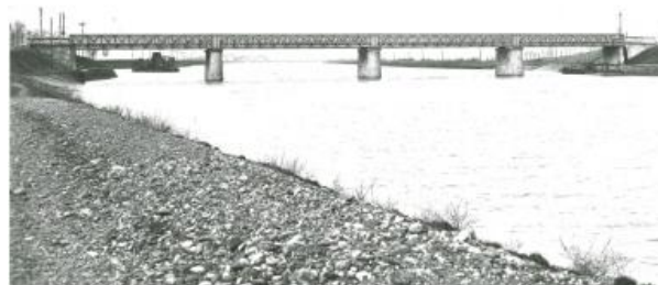
Figure 15 : Pont de la Sucrierie à quatre travées
