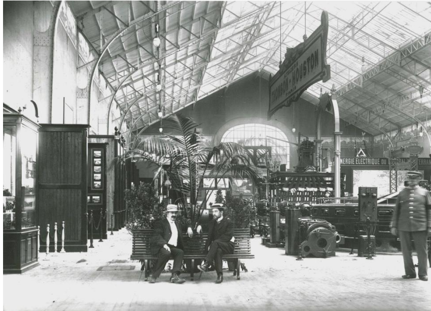
Figure 27 : Photographie de l'intérieur du Palais de l'Énergie à l'Exposition Internationale d'Électricité de Marseille en 1908 (Archives Cusset)
