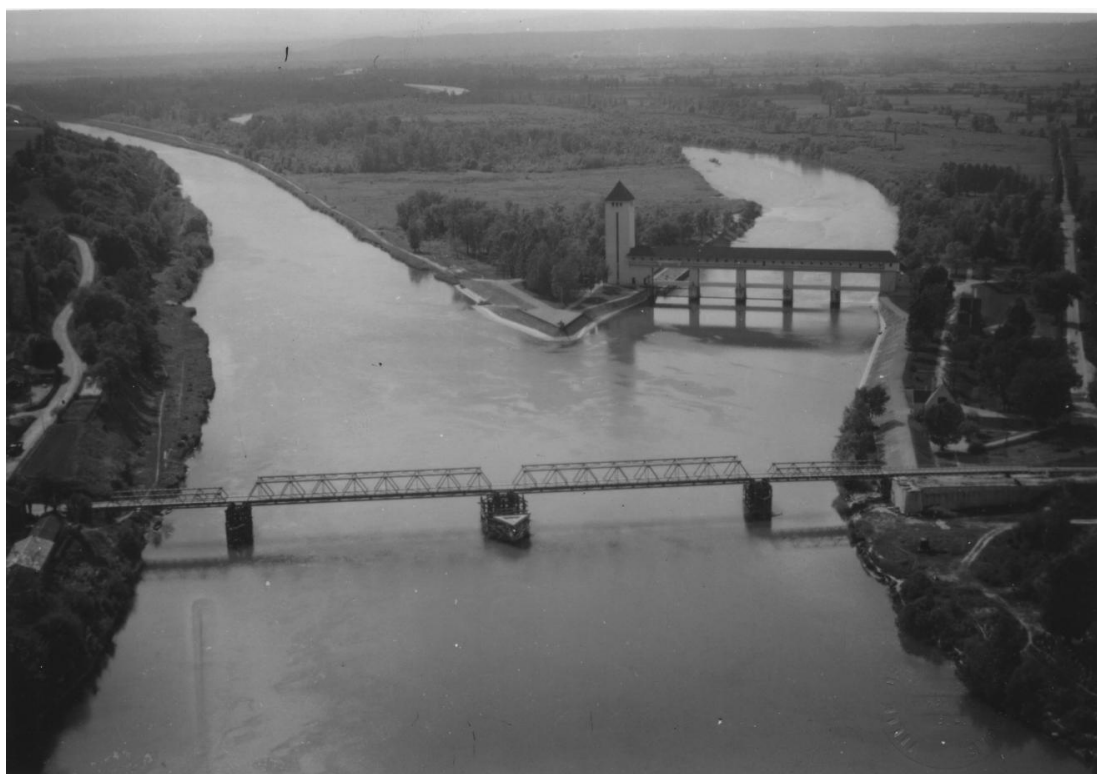
Figure 105 : Vue de la passerelle remplaçant le pont de Jons (Jean Combier – Musée Nicéphore Niepce)
