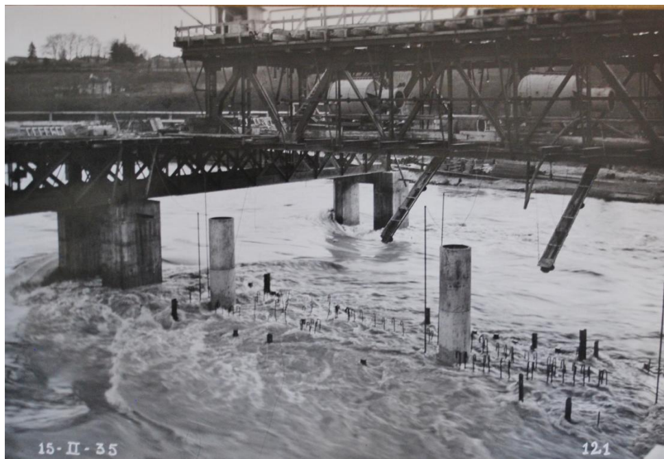
Figure 98 : Crue du 15 février 1935 (A.D.R. 156 J 408)
