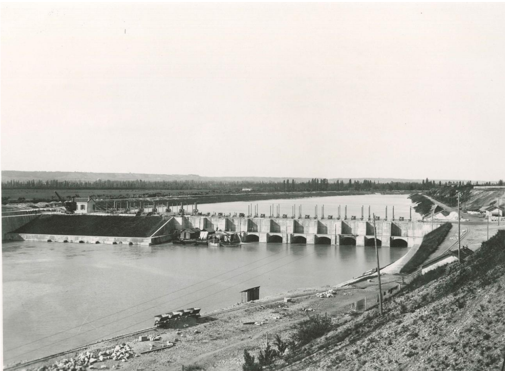
Figure 12 : Mur de garde vu d'aval en 1902 (A. D. R. 2 )
