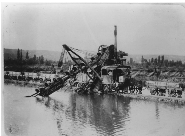
Figure 39 : Déblais du canal de fuite à l'excavateur en 1897 (B.M.L)
