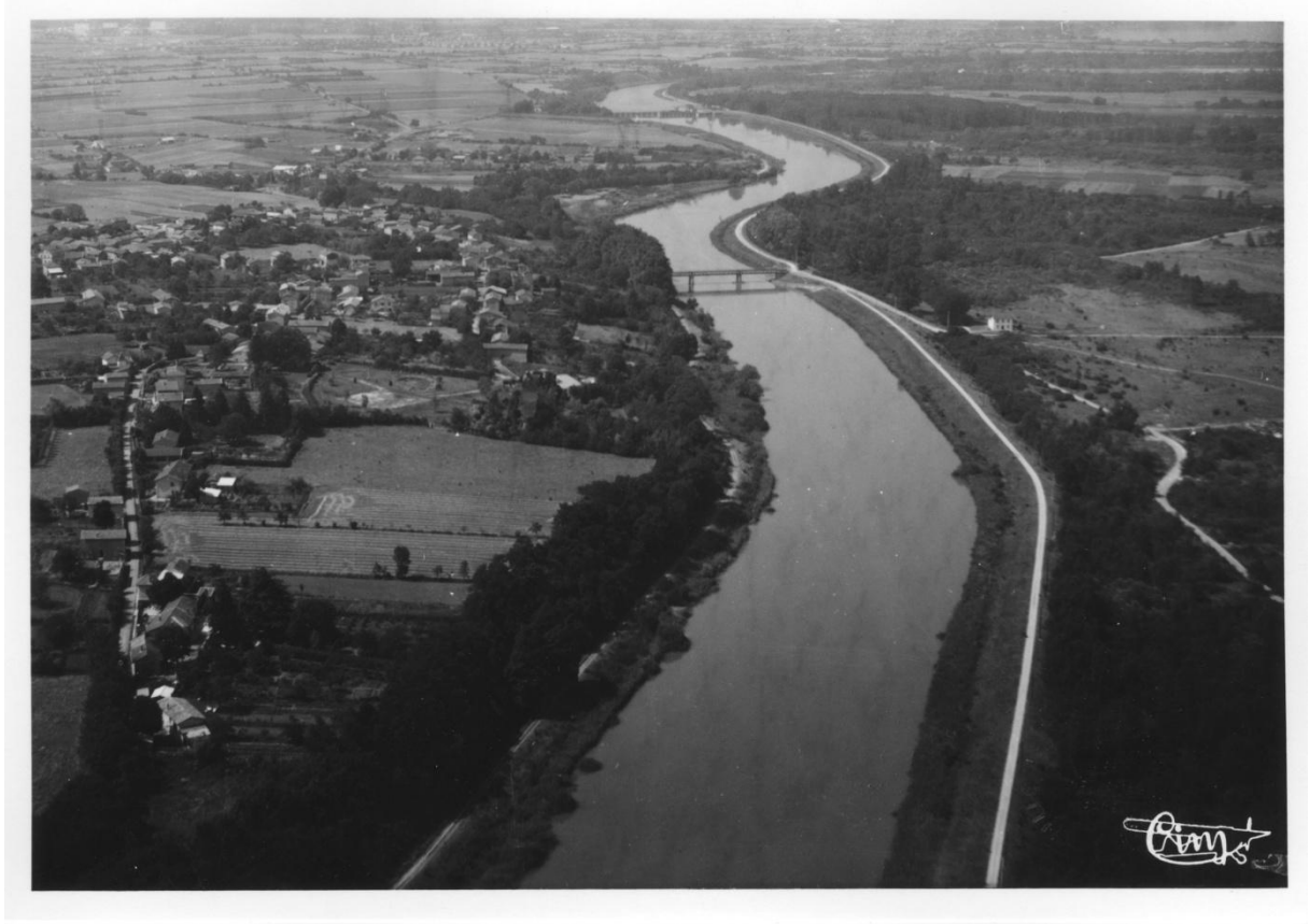
Figure 103 : Vue aérienne du canal de Jonage (Jean Combier)
