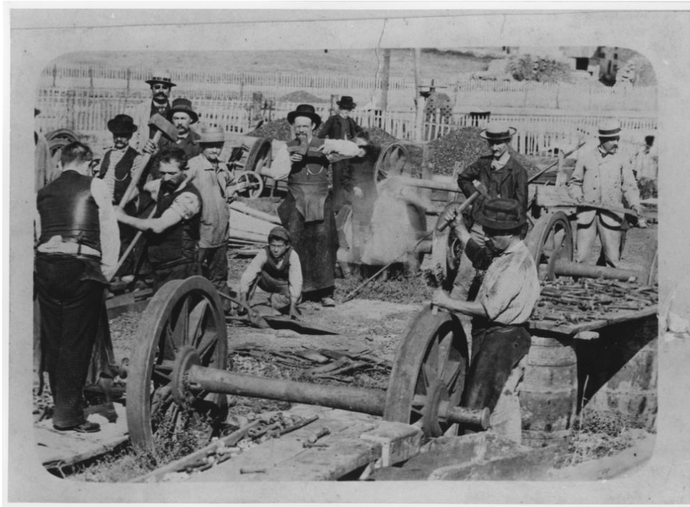
Figure 36 : Charrons sur le chantier du canal de Jonage (B.M.L.)
