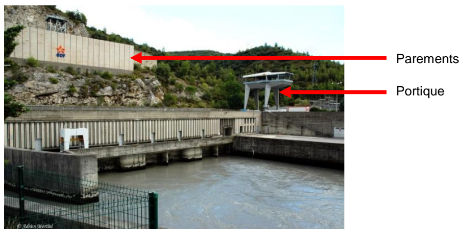
Figure 109 : Centrale hydro-électrique de Jouques
