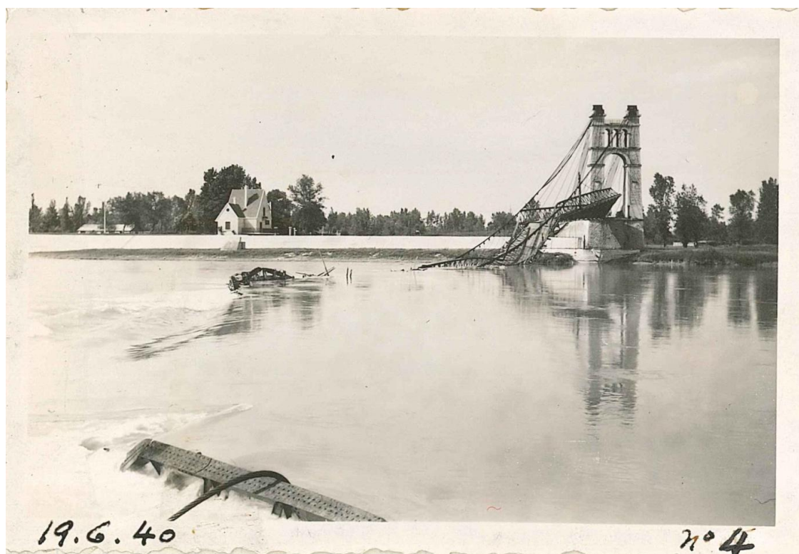
Figure 104 : Pont de Jons détruit (collection Denis Varaschin)
