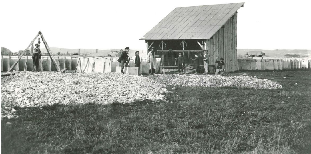
Figure 38 : Plaque photographique n°35 - Chantier des plaques en sidéro-ciment du 2 ème lot
