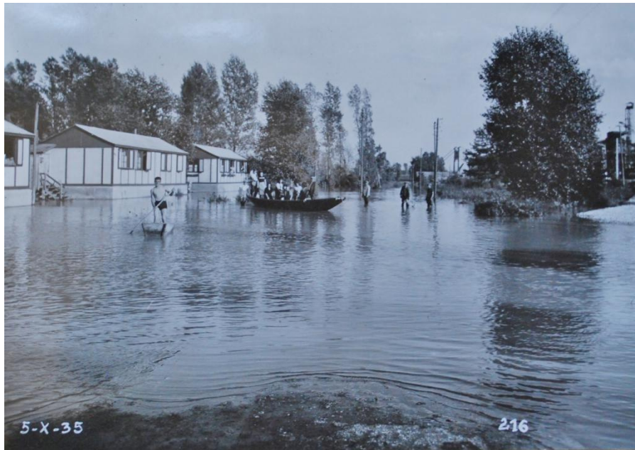
Figure 99 : Berges du barrage de Jons lors de la crue du 5 octobre 1935 (A.D.R. 156 J 408)
