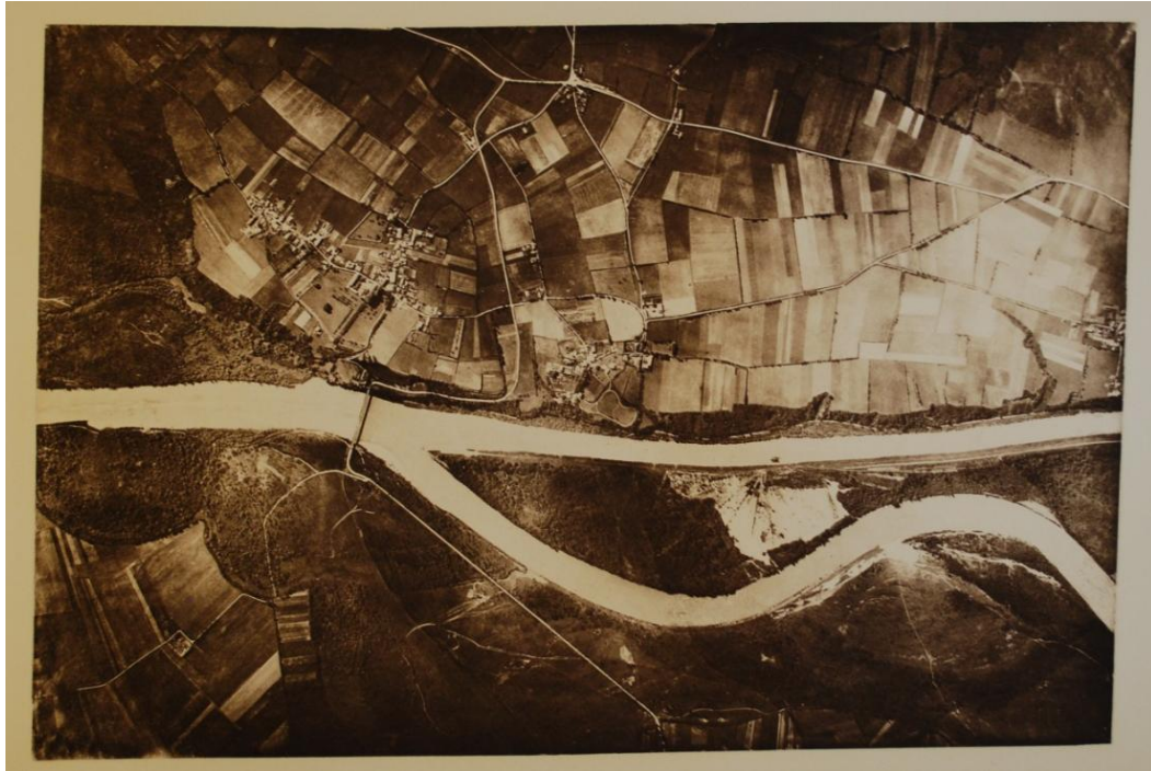
Figure 101 : Feuille 47 G de l'Atlas Photographique du Rhône (Maison du Fleuve Rhône)
