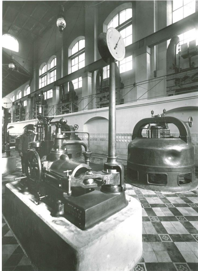
Figure 35 : Plaque photographique 166 – Dynamo excitatrice de 250 HP
