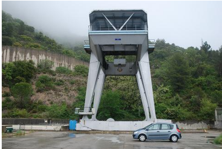
Figure 110 : Portique avant travaux (collection E.D.F.)
