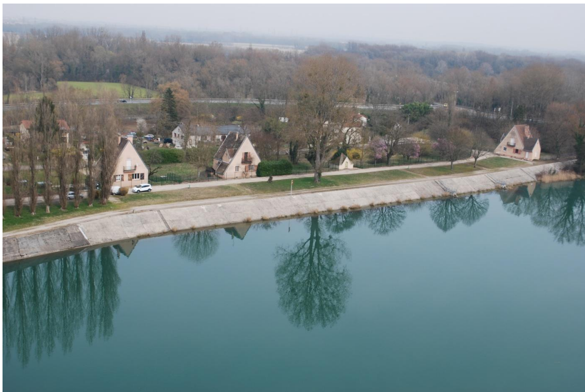
Figure 82 : Maisons d'habitations du barrage de Jons (collection personnelle)
