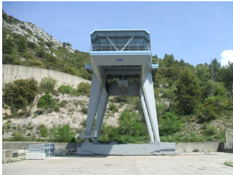
Figure 111 : Portique après travaux (collection E.D.F.)
