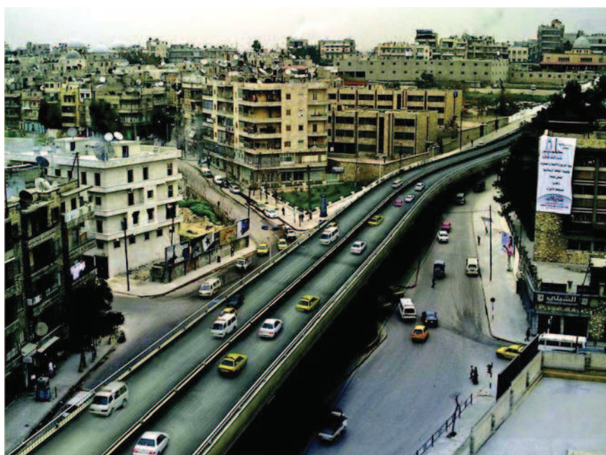
Figure 5.16 : Le pont de Maisaloon près du centre-ville source : Municipalité d'Alep, 2004
