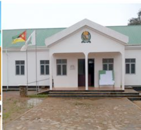
Bâtiment de la municipalité en 2014
