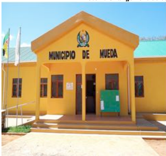
Bâtiment de la municipalité en 2013
