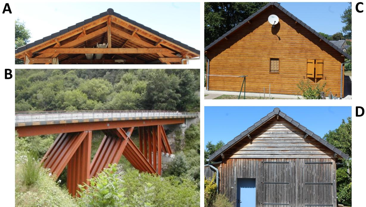
**Figure 6 : A : Charpente en douglas ; B : Pont de Merle en douglas (19) ([www.lacorreze.com](http://www.lacorreze.com)) ; C : Maison avec bardage en douglas traité ; D : Maison avec bardage en douglas (bardage horizontal) et mélèze (bardage vertical) non traités.**
