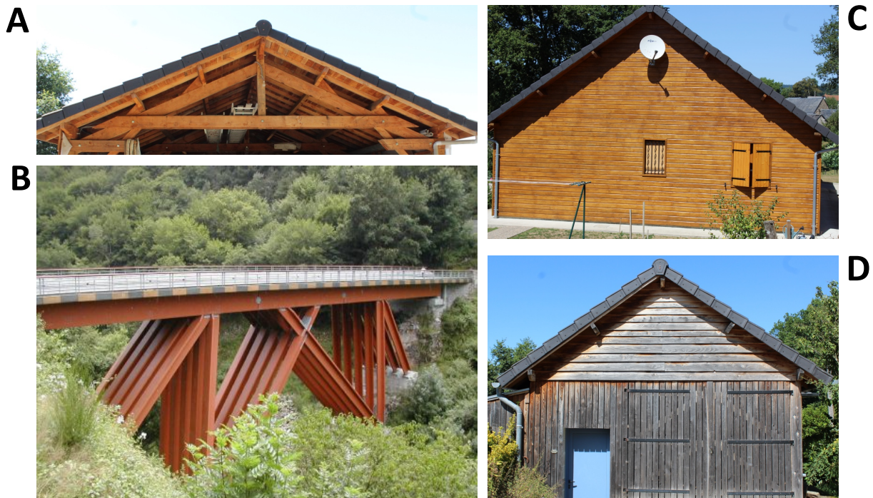
Figure 6 : A : Charpente en douglas ; B : Pont de Merle en douglas (19) (www.lacorreze.com) ; C : Maison avec bardage en douglas traité ; D : Maison avec bardage en douglas (bardage horizontal) et mélèze (bardage vertical) non traités.
