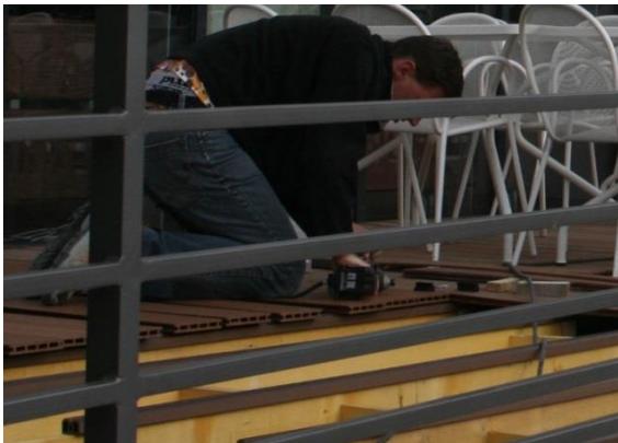
La terrasse se prolonge par un plancher en simili-bois, c'est-à-dire à base de colles et de sciure, ce qui le rend résistant aux intempéries mais peu écologique du point de vue de son contenu en énergie grise, de sa provenance, des composants
