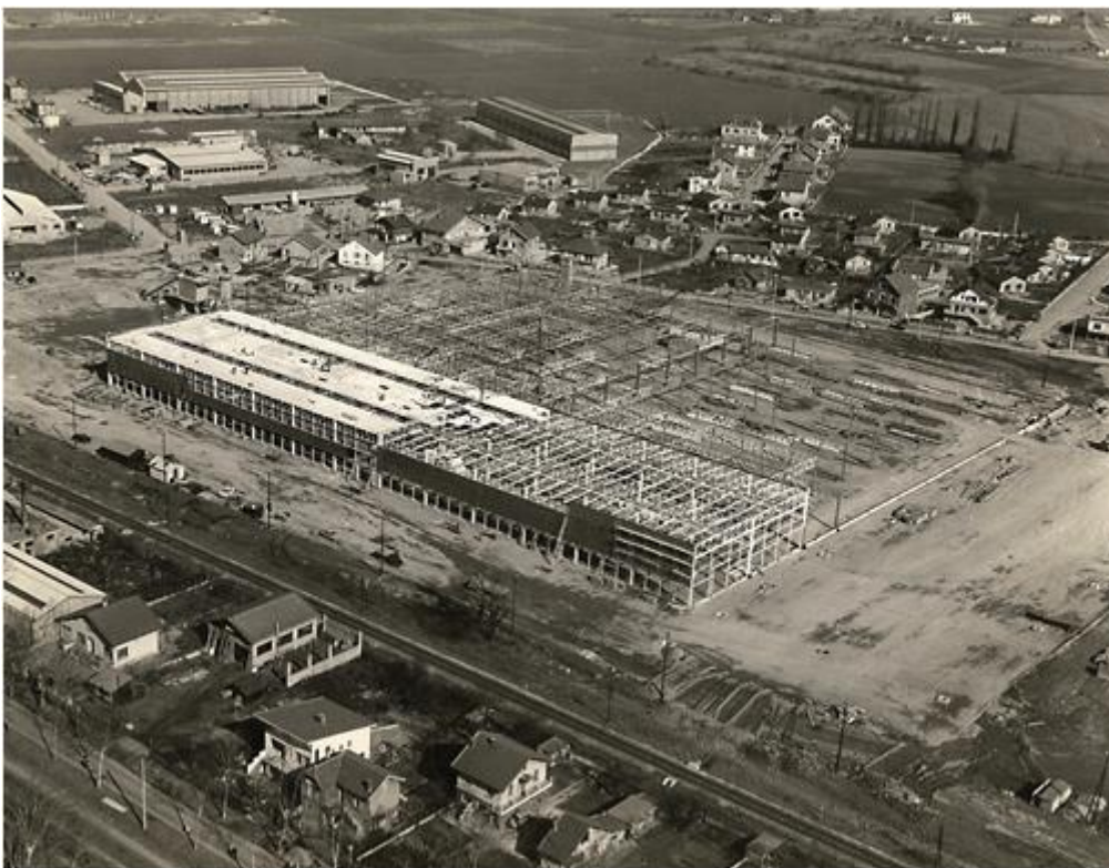
Construction de l'usine Caterpillar, 1963. Collection AME
