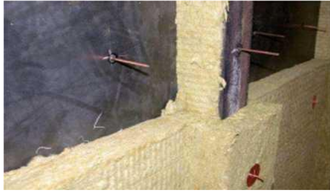
Figure V-4 : Système de tenue de la protection incendie
