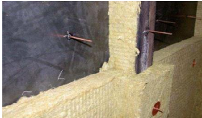
Figure I-1: Isolation incendie sur panneaux métalliques
