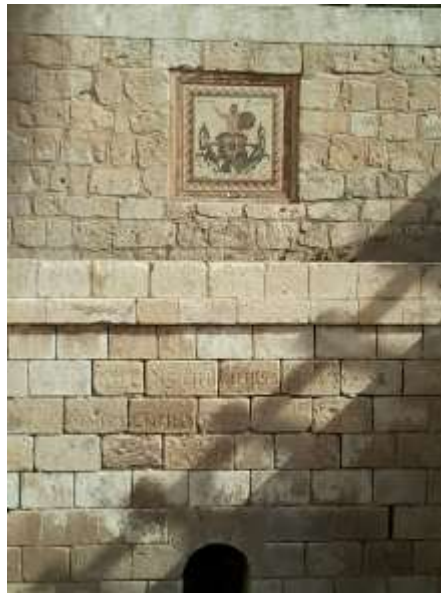
Photo 2.1. Site archéologique au centre-ville de la région de Gafsa
