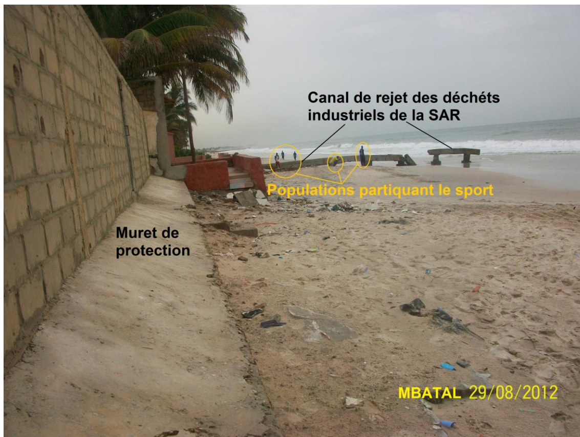
Photo 7 Rejets industriels et risques d'érosion à Mbatal
