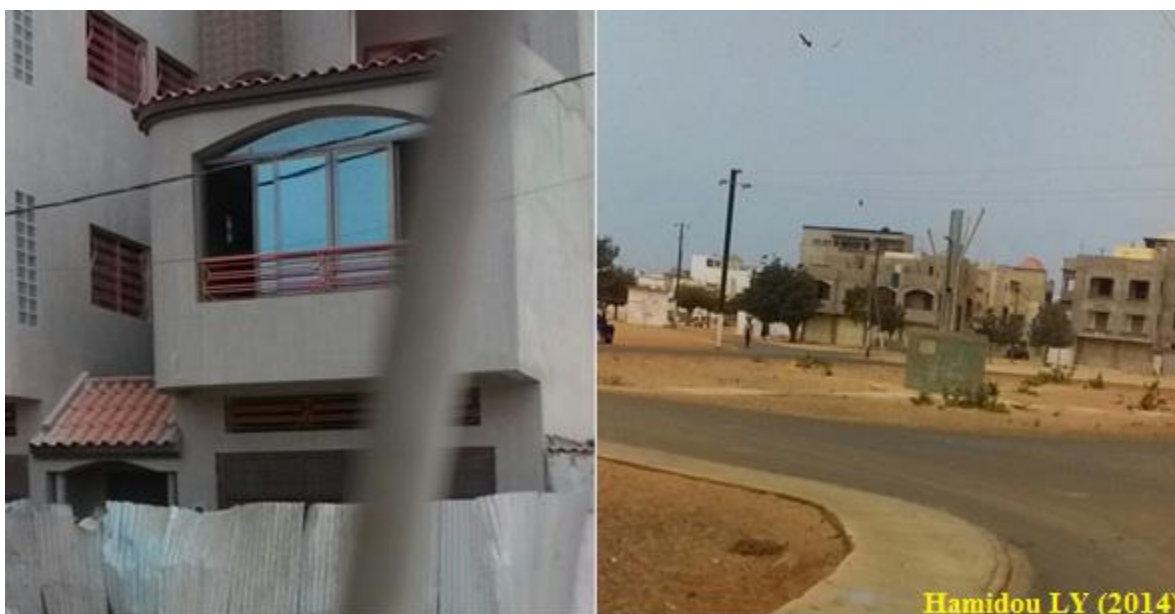
Photo 8 Maisons en construction à la Cité Ousmane Fall
