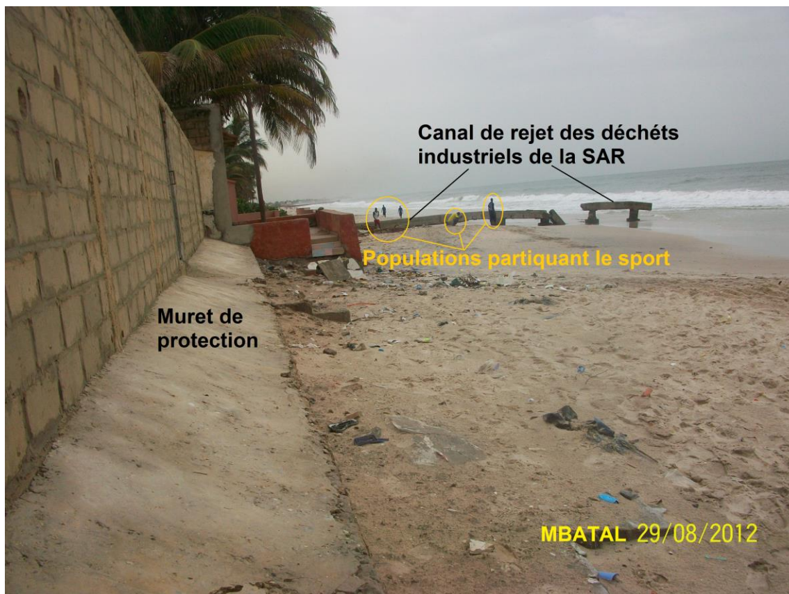
Photo 7 Rejets industriels et risques d'érosion à Mbatal
