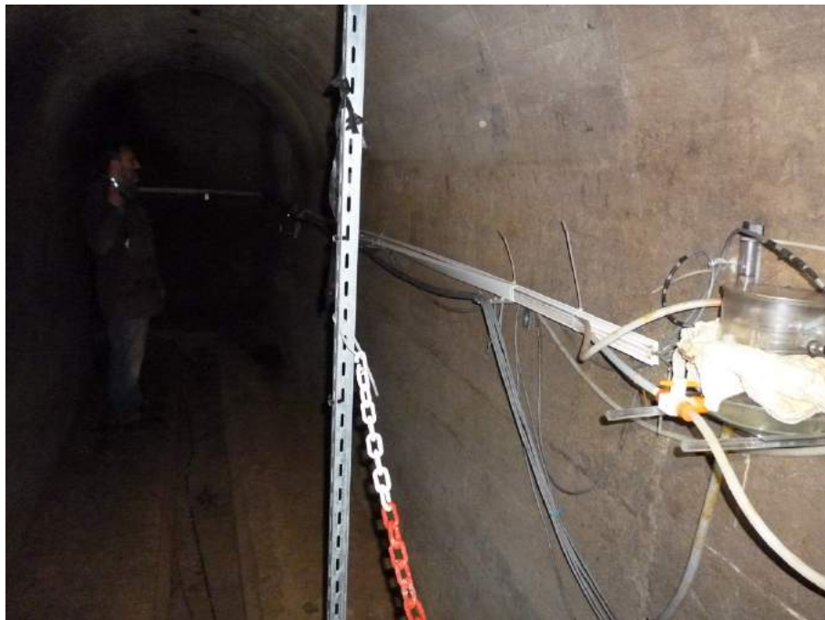
FIGURE A.1 – Extrémité Est de l'inclinomètre LB1 N75°E le long de la galerie principale du bunker.
