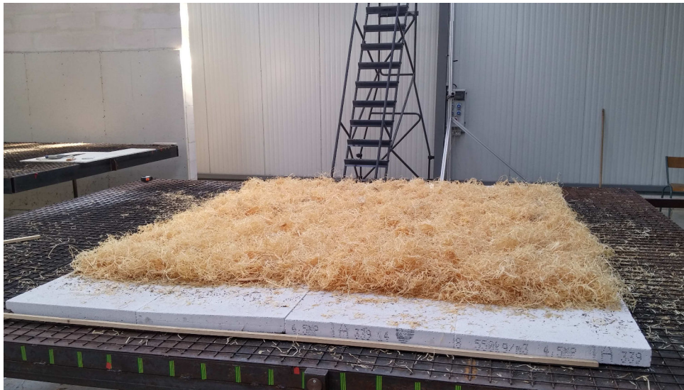
FIGURE 2.26 – Répartition de la frisure sur la surface en béton cellulaire
