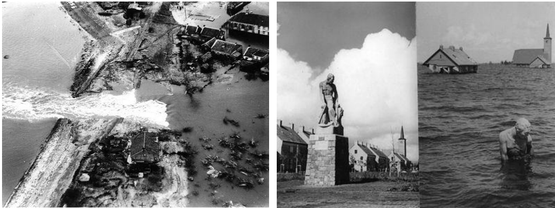
FIGURE 1.2 – Le 1er Février 1953, lors d'une forte tempête, la mer passe par-dessus plusieurs digues aux Pays-Bas (à gauche) et le village Wieringerwerf (avant et après).
