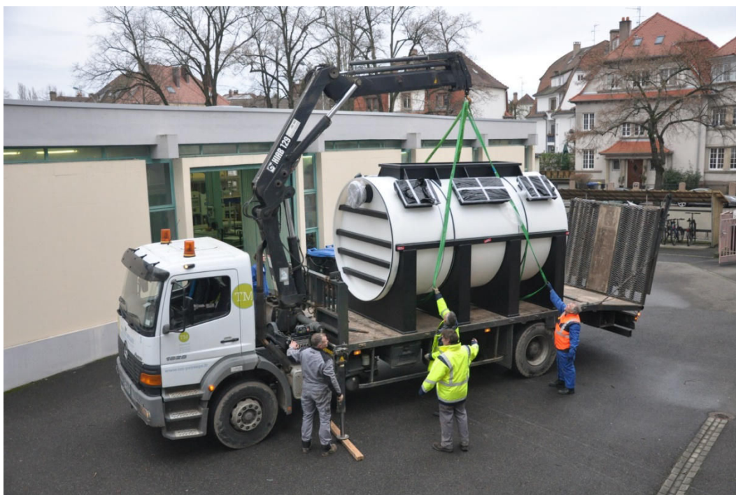
Figure 4-17 : Transport de la cuve par camion
