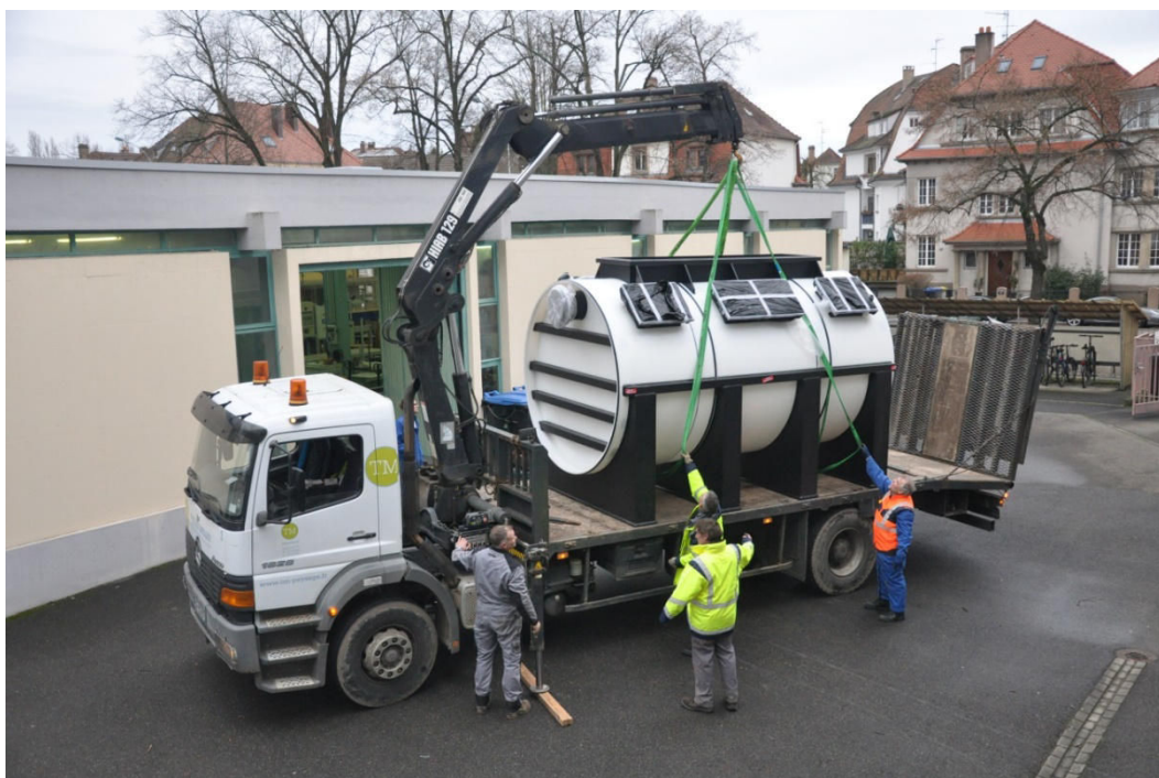
Figure 4-17 : Transport de la cuve par camion
