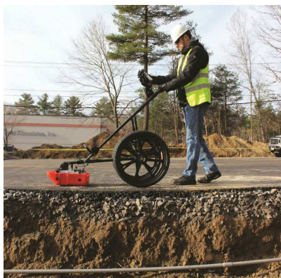
(a) Contrôle de la chaussée
