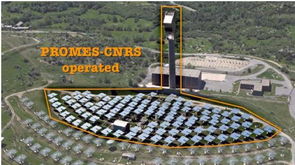
Figure 56 – Vue aérienne de la tour de la centrale Thémis et du champ d'héliostats actuellement en activité
