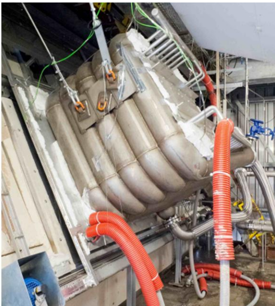
Figure 59 – Cavité active présente au sein du foyer mini-Pégase avant son isolation – Vue de côté mettant en évidence les enroulements des canaux
