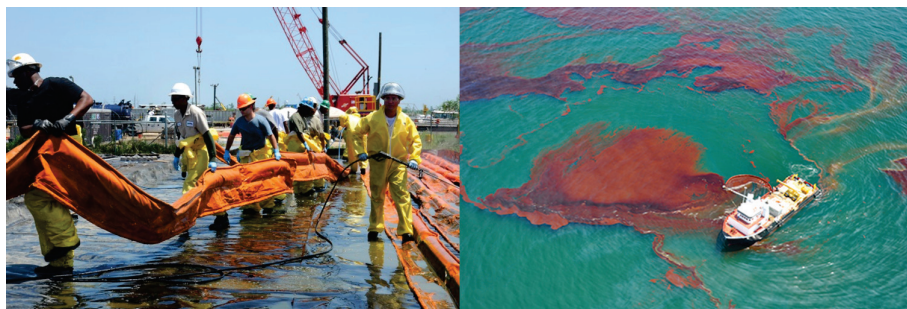
Figure 1.4 – Photographies de barrages flottants et de bateau en cours de récupération [102, 113].
