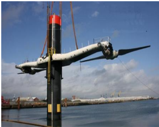
Figure 4.15: Hydrolienne MCT double rotor (Pales en composite de 8m de long et une puissance de 1.2 MW)
