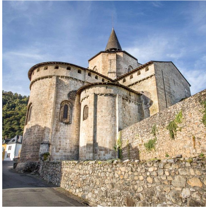
Figure 114 : Abbatale de Saint-Savin-en-Lavedan. Source : www.saint-savin65.com .
