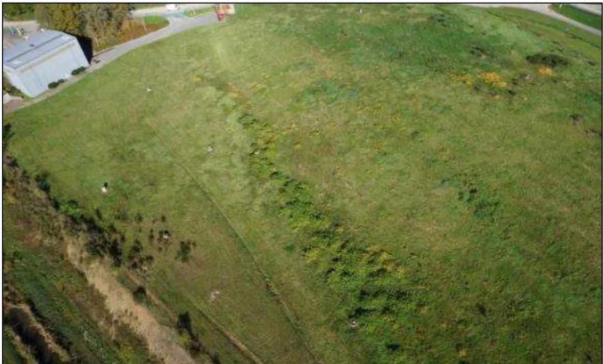
Figure 2.12 : vue aérienne 1/2 de détail (Nord-Ouest) sur la végétalisation du massif de déchet de l'ISDND du SICTOM Sous -Vosgien (90) - Drone Atelier d'Ecologie Urbaine/Terranodrone.
