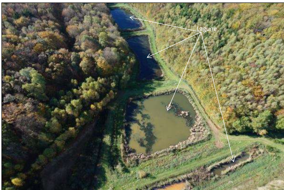
Figure 2.15 : vue aérienne des Lagunes de l'ISDND du SICTOM Sous- Vosgien (90) - Drone Atelier d'Ecologie Urbaine/Terranodrone – 30 Octobre 2013
