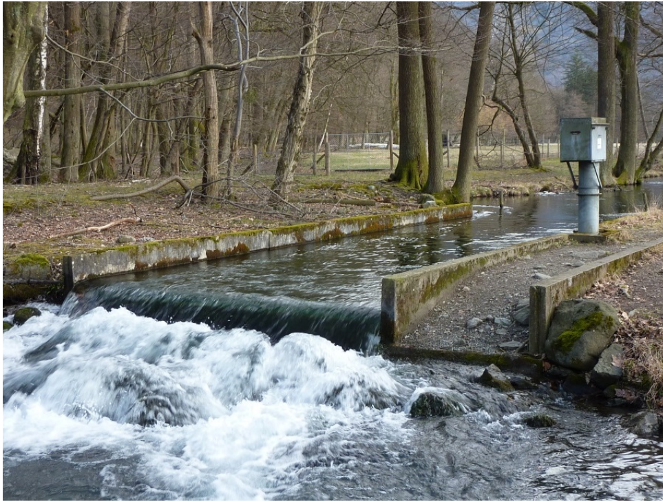
Station hydrométrique avec seuil dans le parc du château de Vizille (Isère, France). Source : A. Despax.
