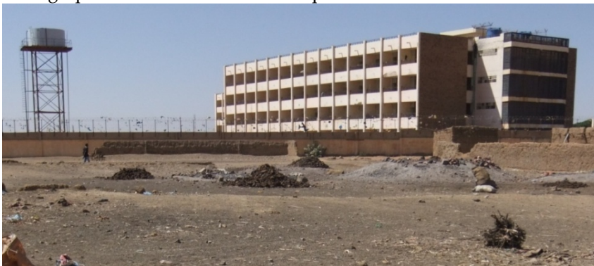
Photographie 51 : Réservoir surélevé du campus de l'université islamique d'Omdurman
