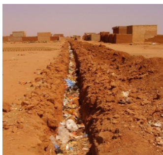
Photographie 58 : Tranchée prévue les canalisations d'un micro-réseau
