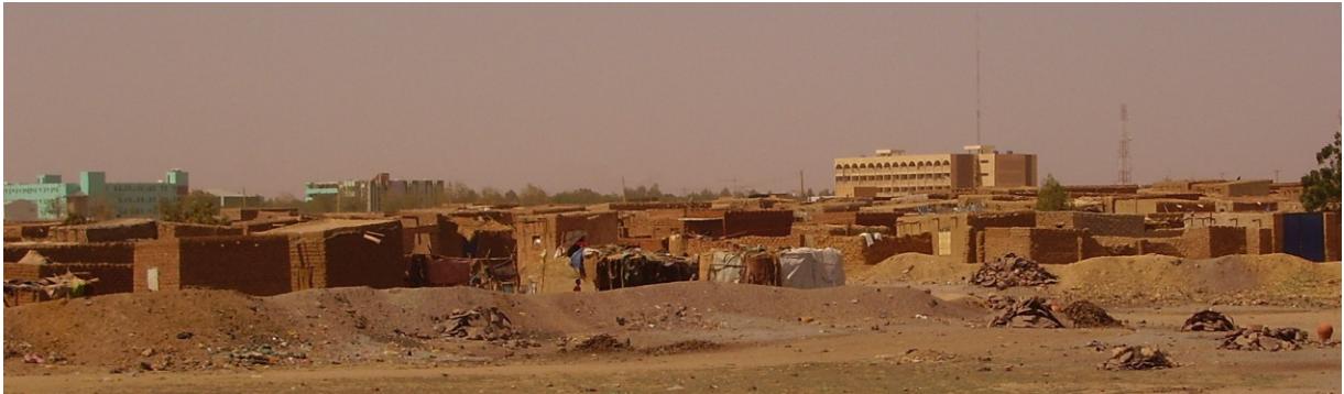
Photographie 12 : Vue vers le nord ouest du quartier de Zurgan
