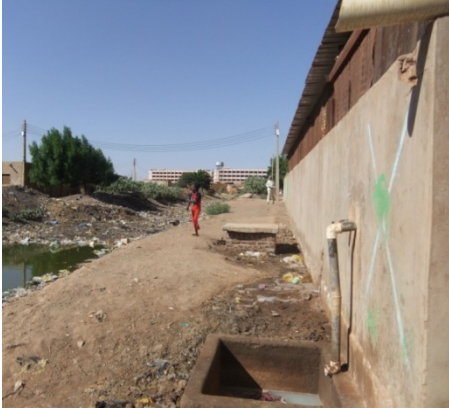
75 : évacuation de l'eau à la pâtisserie dans une petite fosse en béton
