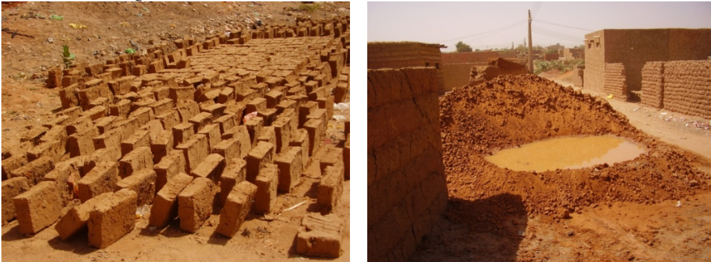
Photographie 50 : Utilisation de l'eau pour la fabrication artisanale des briques de construction
