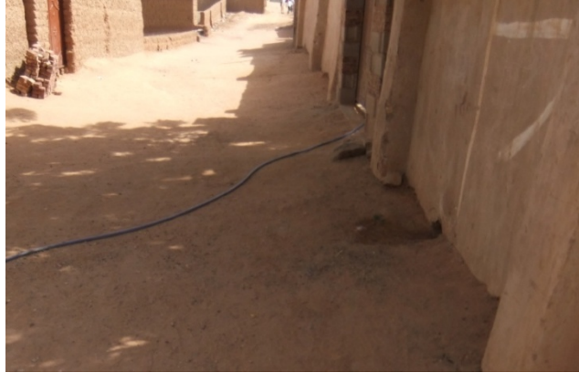
76 : dérivation du réseau à travers la rue à côté l'ouverture pour l'évacuation des eaux usées
