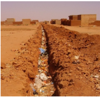
Photographie 58 : Tranchée prévue les canalisations d'un micro-réseau
