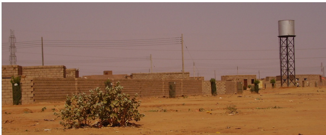
Photographies 32 : Iskan, bloc 99, quartier replanifié en 2009 par le gouvernement, habitation en parpaing
