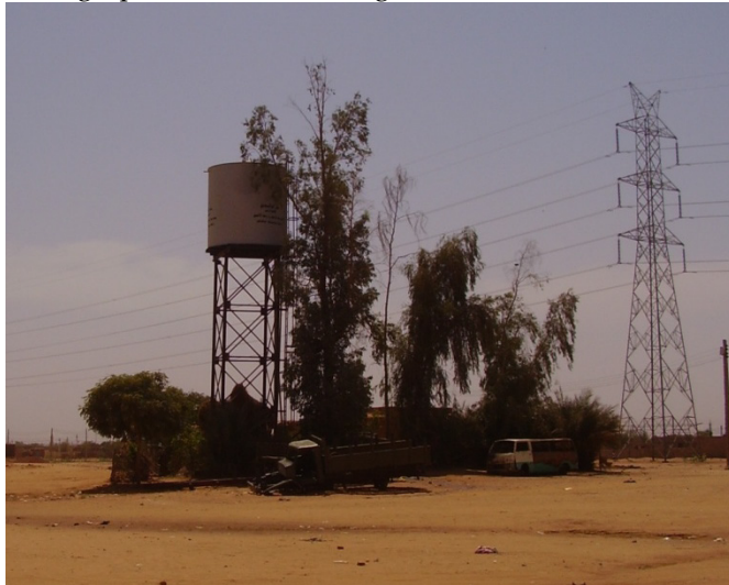
Photographies 52 et 53 : Forage et réservoir du bloc 57
