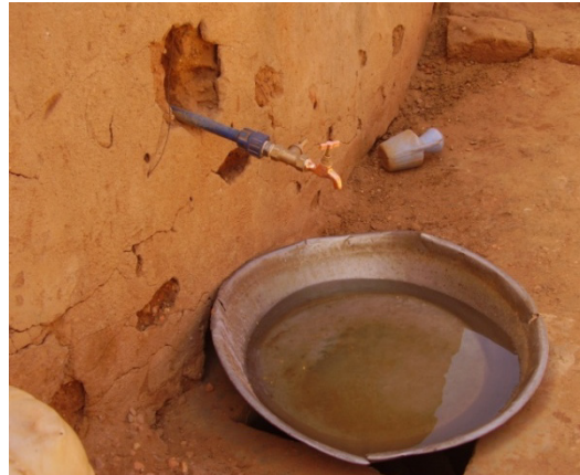
La connexion passe au sol où à travers le mur d'enceinte (Zurgan à gauche ; bloc 27 Dar es Salam à droite).
