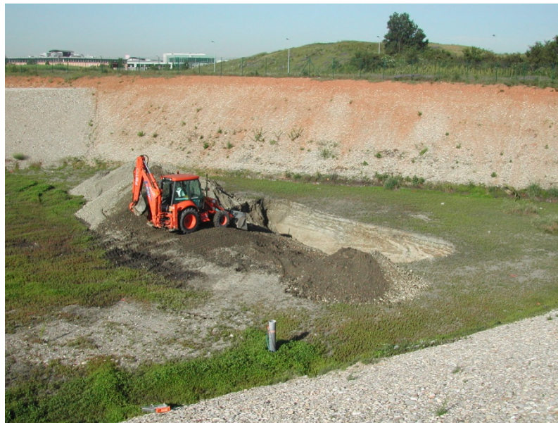
Figure 8 : Réalisation de l'excavation de la zone A. La paroi d'excavation visible est celle qui a été décrite sédimentologiquement (Goutaland, 2008)
