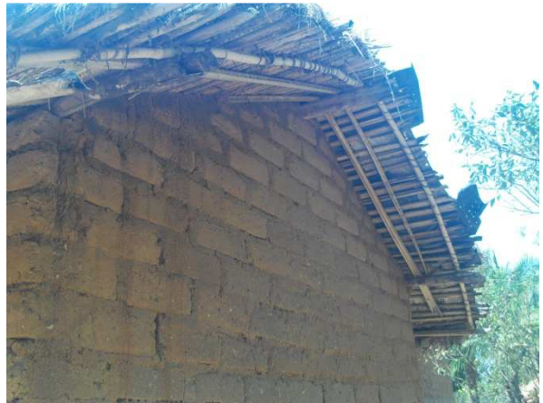
Photo 41. Charpente d'une maison faite en feuilles de palme
