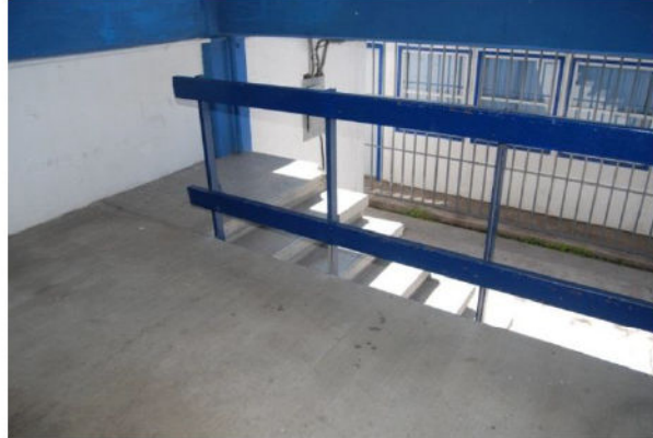
Escalera del edificio B U1.0.3F Fuente: Fotografía de la autora (2013).
