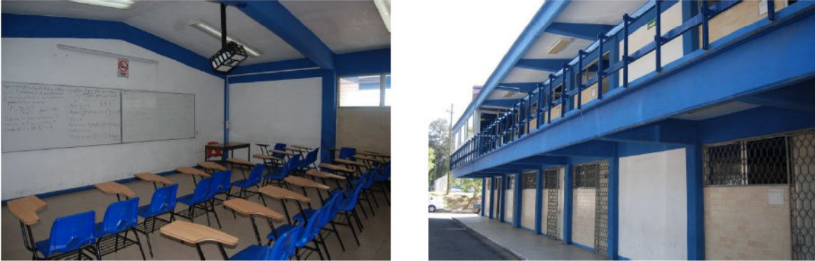
Aulas y fachada del edificio B U1.0.1F Fuente: Fotografía de la autora (2013).
