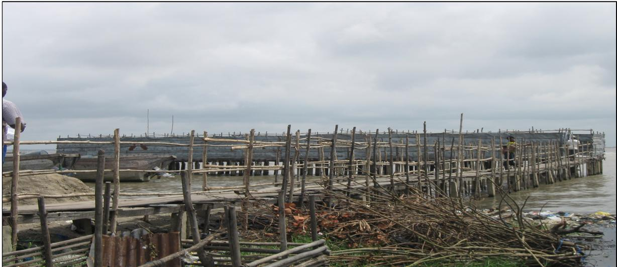
Il s'agit de la plus grande latrine sur pilotis du quartier Agbato. Elle repose sur des piliers en béton et comporte plus d'une vingtaine de cabines.
