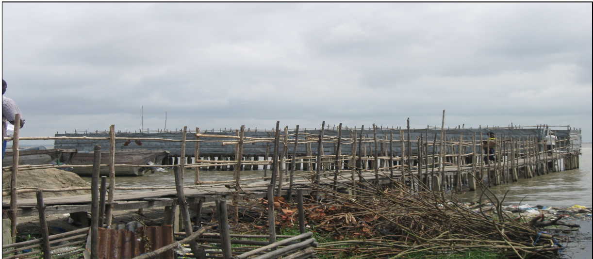
Photo 9 : Latrine sur pilotis dans le quartier Agbato
