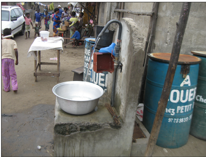
Photo 18 : Points d’eau potable privés installés sur la plage à Enagnon
