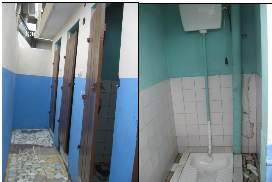
Latrine publique à fosse transformée en latrine moderne avec chasse d'eau
