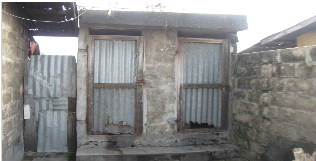
Photo 13 : Latrine privée dans une concession à Kpankpan
