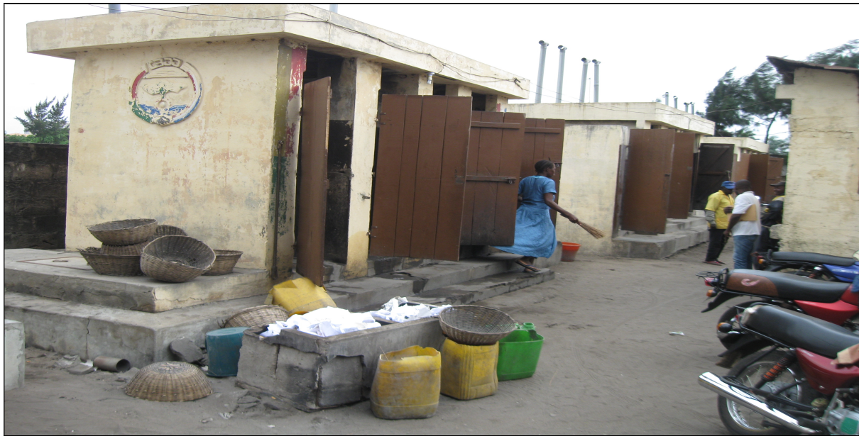
Photo 12 : Latrine à fosse publique à Enagnon
