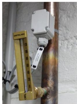
Figure 41 - Capteur de température que se trouve sur le tuyau aller et retour du plancher chauffant
