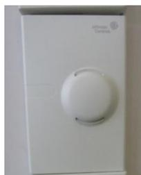
Figure 34 - Sonde de  $\text{CO}_2$
