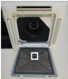
**Figure 130** - Capteur de température placé au niveau de la grille de reprise d'un VCV
