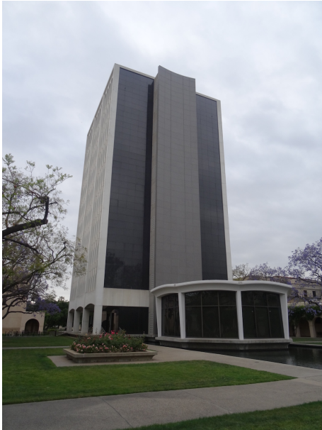
Figure 2.3 – Bâtiment de la Millikan Library sur le campus de Caltech, Pasadena, Californie. Ce bâtiment instrumenté depuis 1968 et équipé d'un excitateur à balourd à son dernier étage est la structure la plus étudiée dans la communauté (p. ex. Clinton et al., 2006) sans que toutes les observations ne puissent aujourd'hui encore être expliquées (problématique de l'interaction sol-structure). Il a subi des dommages lors du séisme de San Fernando en 1971.
