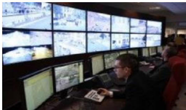
Mur d'écran du centre de supervision urbain
