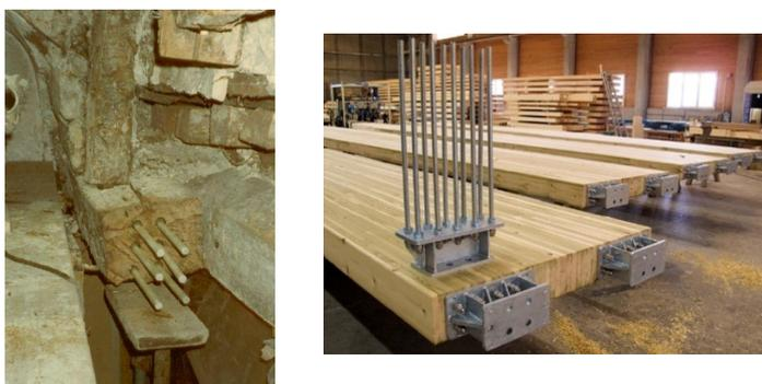
*Figure I-6 : 1/ Goujons en fibre de verre utilisés en rénovation (photo Bepox),
