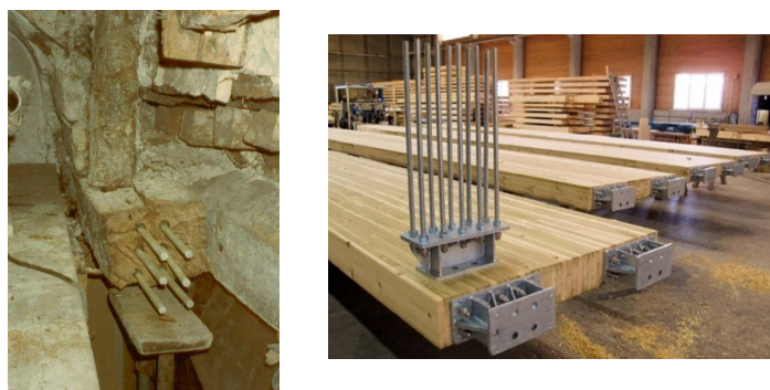
Figure I-6 : 1/ Goujons en fibre de verre utilisés en rénovation (photo Bepox), 2/ Goujons acier utilisés avec BLC (photo Simonin)
