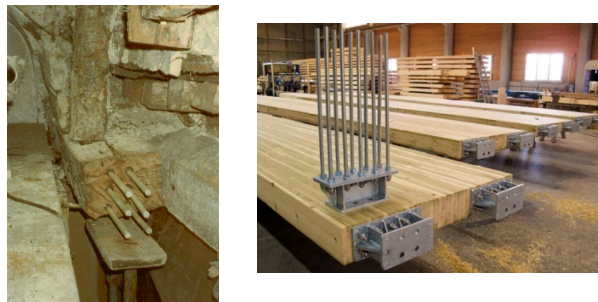
Figure I-3 : Goujons collés (photo Bepox, Simonin)
