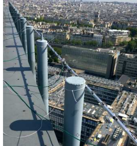
(b) Mesure en environnement urbain au sommet d'un immeuble, Paris [97].
