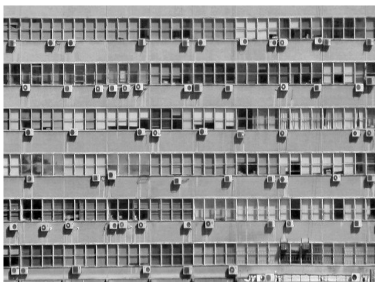
Figure 2: Utilisation considérable des systèmes de climatisation dans le secteur résidentiel
