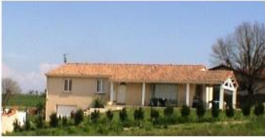
Photo n°28 Le Monastère en Aveyron (source Agence Place)
