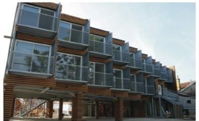
Photo n°13 résidence conteneurs maritimes habitat 21 Bègles (source Google Images)
