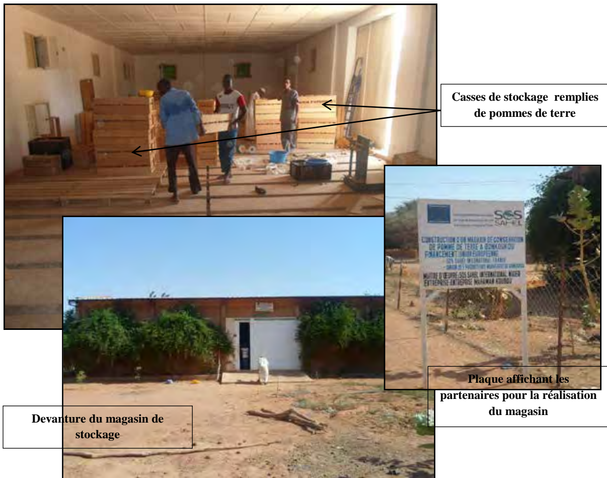
Planche photo n° 3 : Magasin de stockage de pomme de terre à Bonkougou, cofinancé par la Coopérative des Maraîchers de Bonkougou et SOS Sahel International (Union Européenne), 2013
