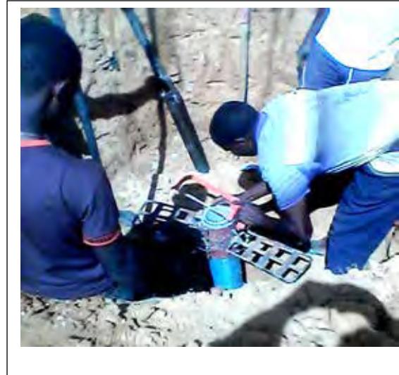
Photo n° 9 : Fonçage d'un forage à Labango, 2012
