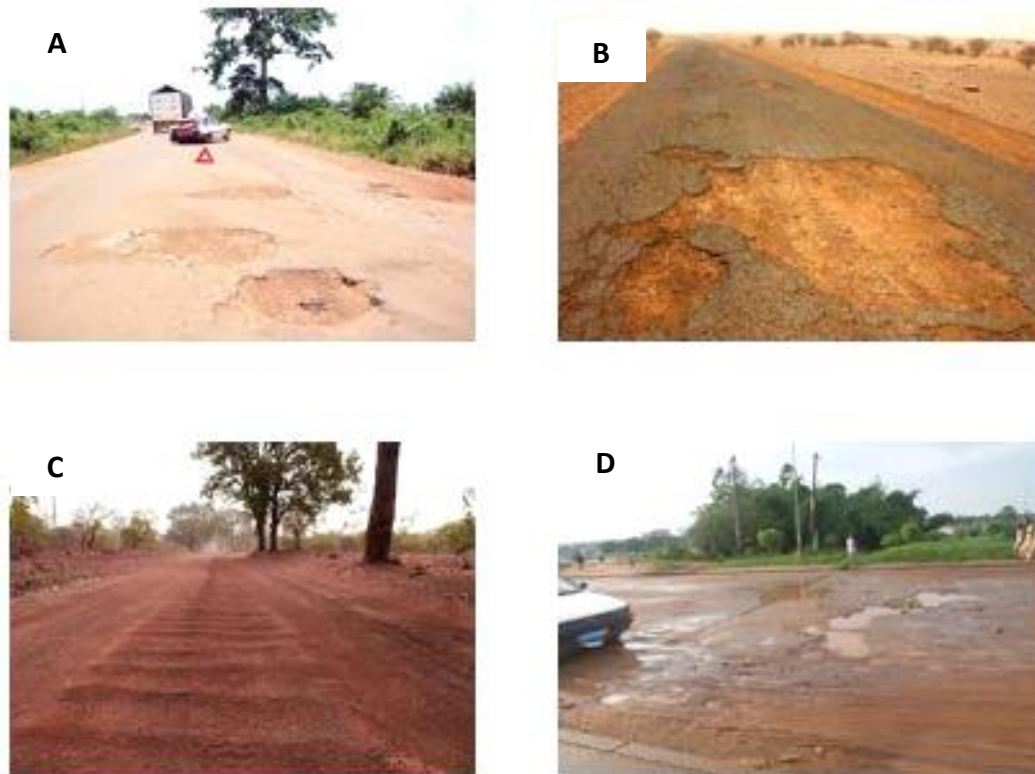
Figure 0-2: Exemples de dégradations précoces de chaussées en latérite. A) Nids de poule générés par une ségrégation granulométrique (route Torodi). B) Nids de poule dus à un défaut de portance (Route Tahoua-Arlit). C) Tôle ondulée (route rurale en latérite dans la zone de Say). D) Défaut de portance causé par un problème d'assainissement (Zone de Fillingué).
