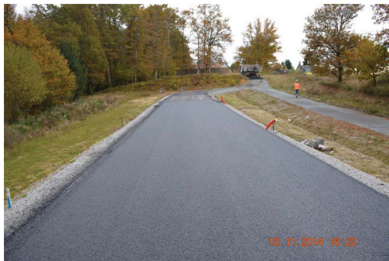
Figure 4.21: Photographies après la pose du BBSG en couche de roulement
