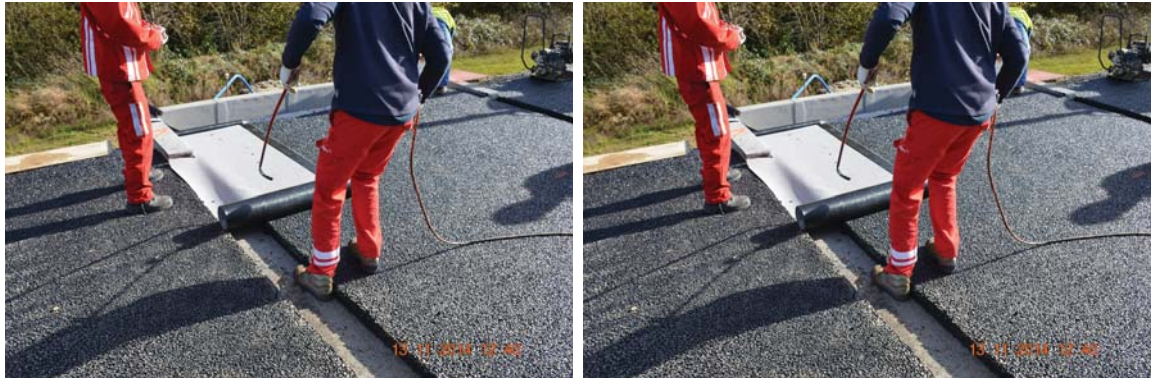
Figure 4.20: Photographies de la pose de l'étanchéité supérieure en zone A
