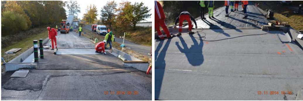
Figure 4.18: Photographies de l'étanchéité inférieure en zone A après la pose de l'enrobé de reprofilage
