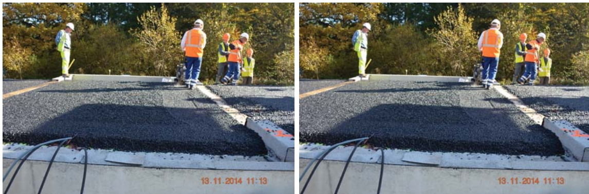
Figure 4.19: Photographies de la pose du BBDR
